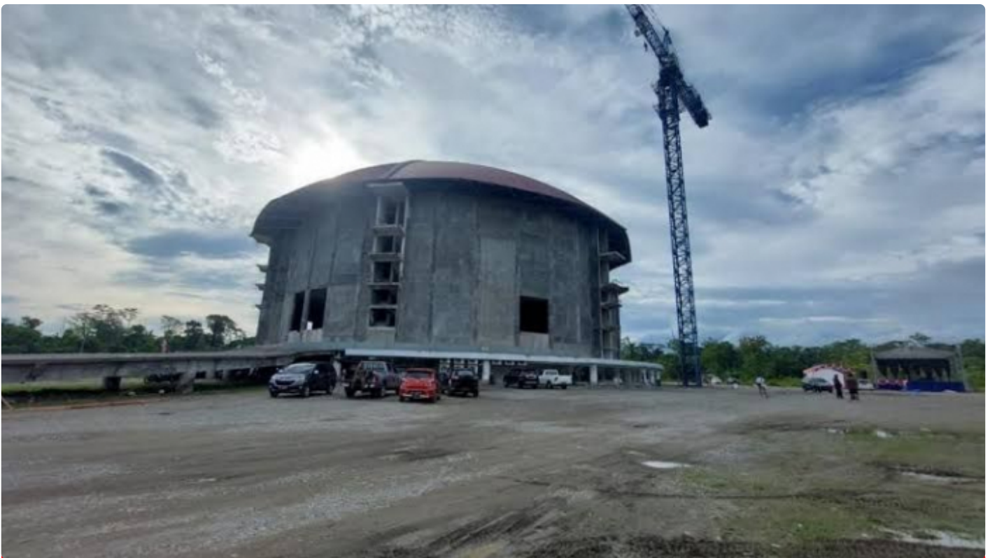
Pembangunan Gereja Kingmi Mile 32
